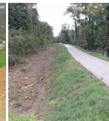
Déboisement avant travaux
