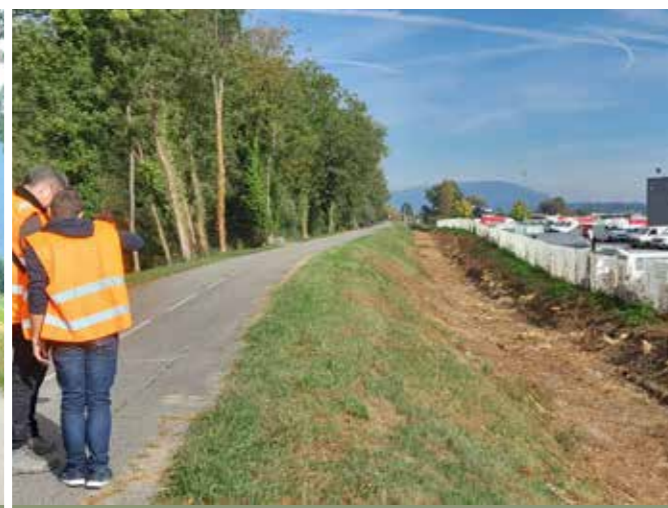
Visite technique approfondie (VTA) des digues
