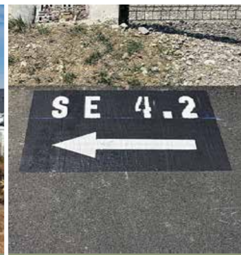
Marquage des PK sur les digues
